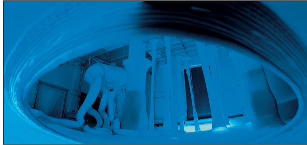
Jedna od instalacija
